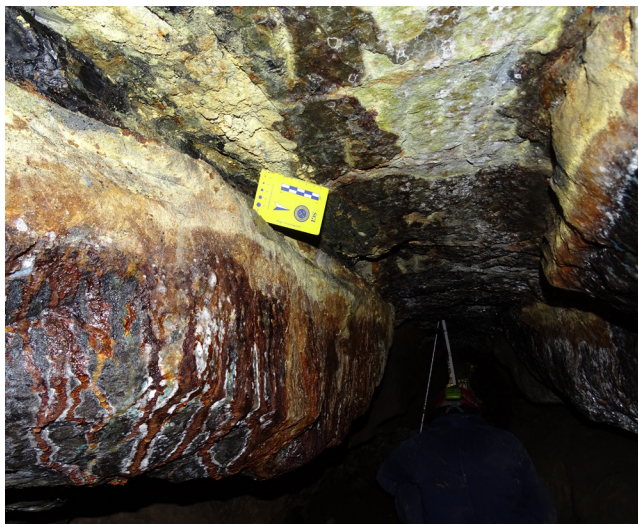
FIG. 3: Volta della galleria interamente costituita da legno carbonificato ricoperto da diffuse mineralizzazioni secondarie.
